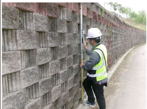
경사계를 이용한 경사도 측정
