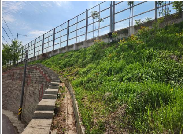
상부 성토부 전경
