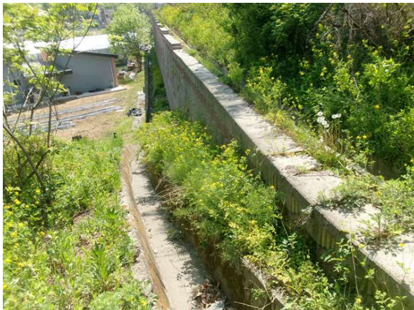
하부 배수로 전경
