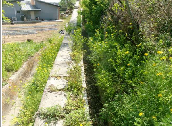
상부 배수로 전경
