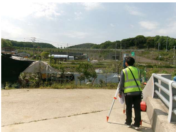
광파기를 이용한 측량 작업
