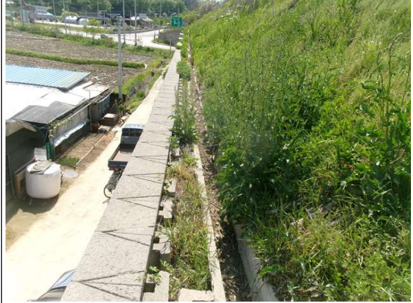
상부 배수로 전경
