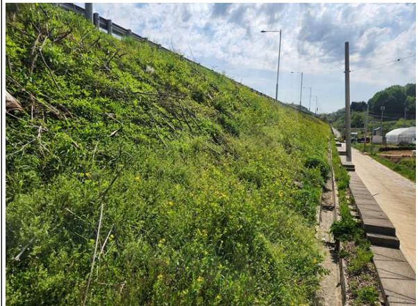
상부 성토부 전경
