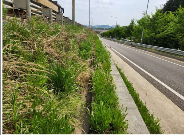
상부 배수로 전경
