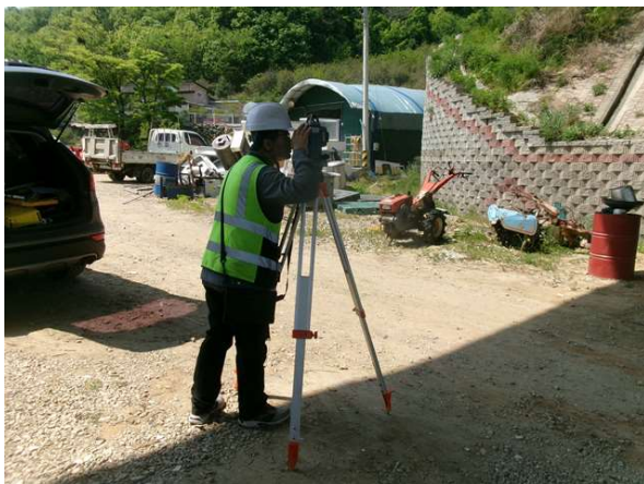
광파기를 이용한 측량 작업
