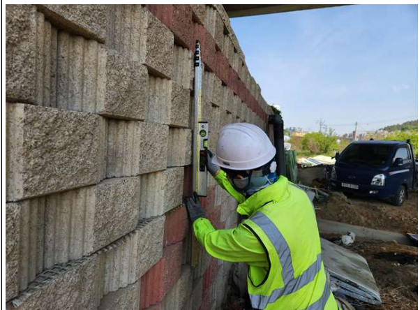
경사계를 이용한 경사도 측정
