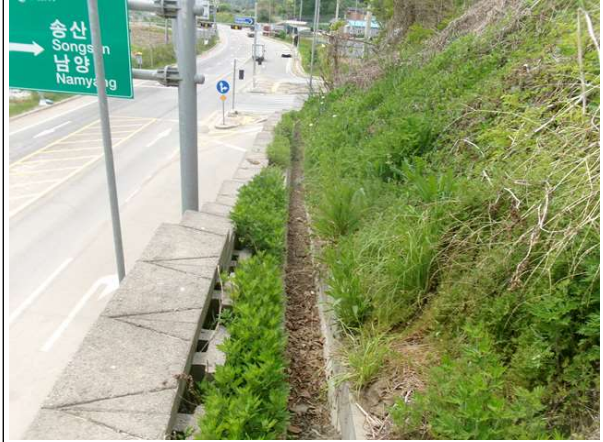
상부 배수로 전경
