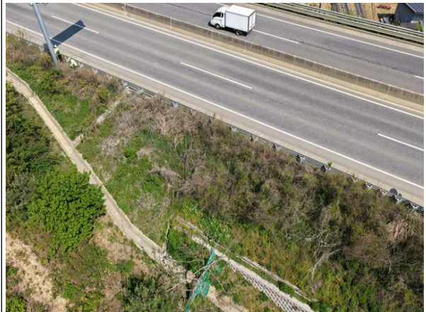
상부 성토부 전경
