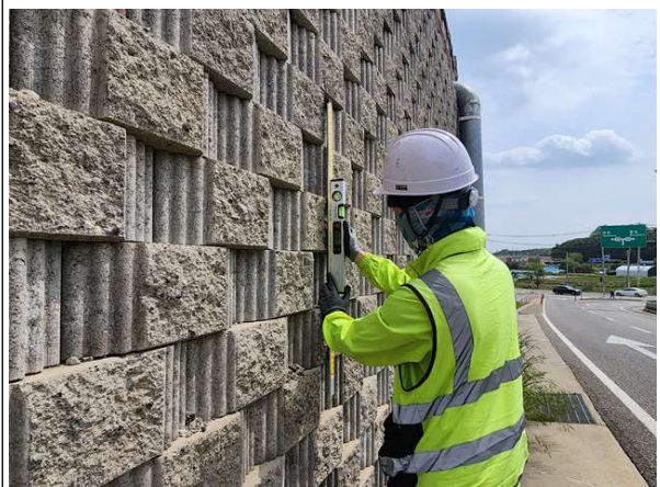
경사계를 이용한 경사도 측정
