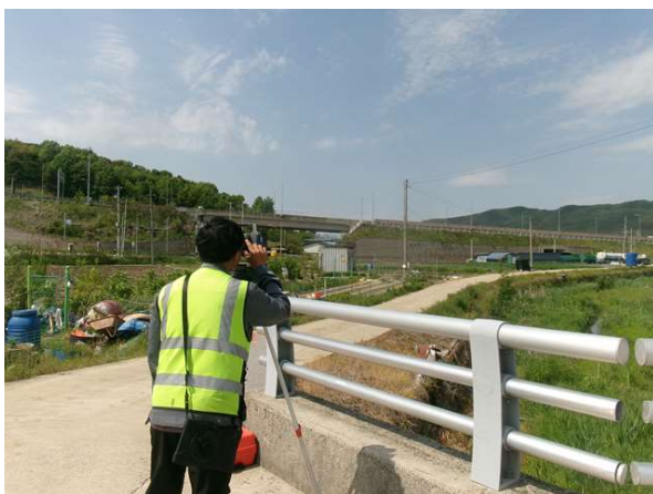
광파기를 이용한 측량 작업
