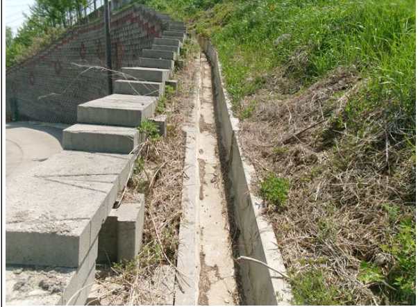
상부 배수로 전경
