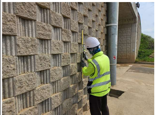
경사계를 이용한 경사도 측정
