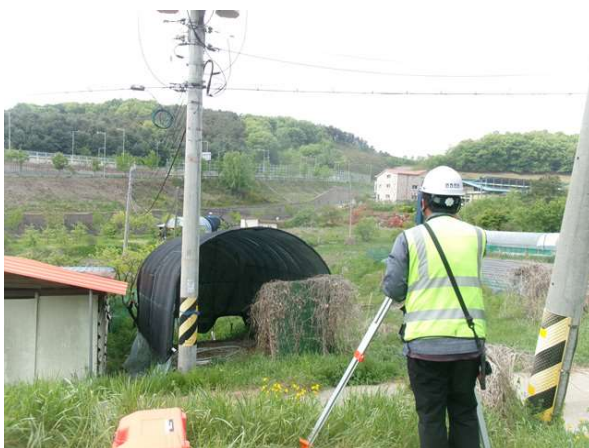
광파기를 이용한 측량 작업
