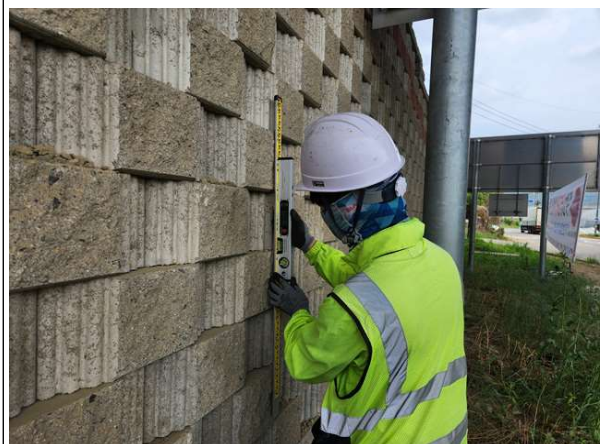
경사계를 이용한 경사도 측정
