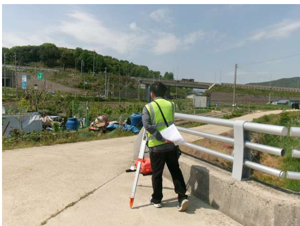
광파기를 이용한 측량 작업
