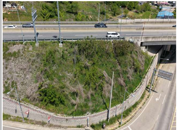
상부 성토부 전경
